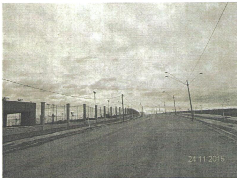
Foto 2 – Visão geral do empreendimento, rua externa
